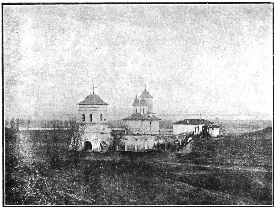
81. M-rea Gura Motrului: vedere generală.
